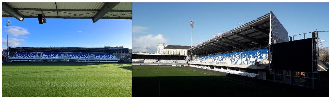
Ce projet commandité en conception construction à NGE BATIMENT par la Mairie de Vannes, s'est articulé autour de deux grandes phases : la démolition de l'ancienne tribune métallique de 1 166 places et la reconstruction d'une nouvelle tribune de 2 500 places dans une structure mixte béton/métal comprenant un étage, proposant des toilettes ou encore des buvettes.
