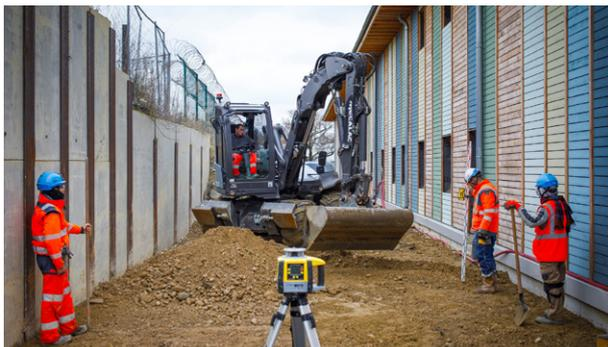
Méalac (pelle mécanique électrique) déplaçant des granulats recyclés. Le bardage du bâtiment a été réalisé avec des palettes de réemploi.
