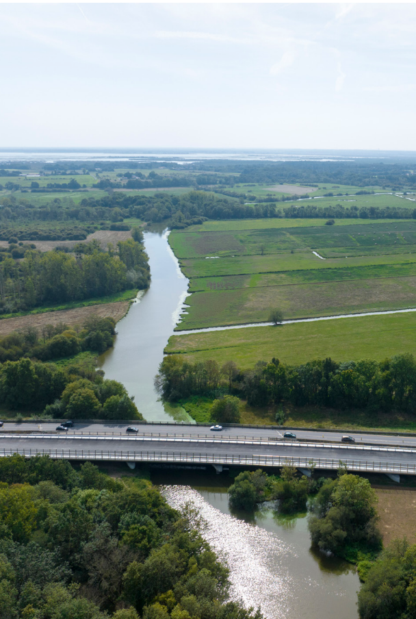
▼ Viaduc de l'Acheneau
