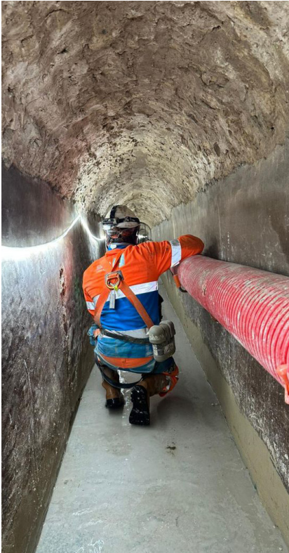
Intervention sur les canalisations du château de Fontainebleau
