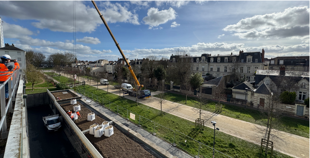
▼ Toiture végétalisée à Angers
