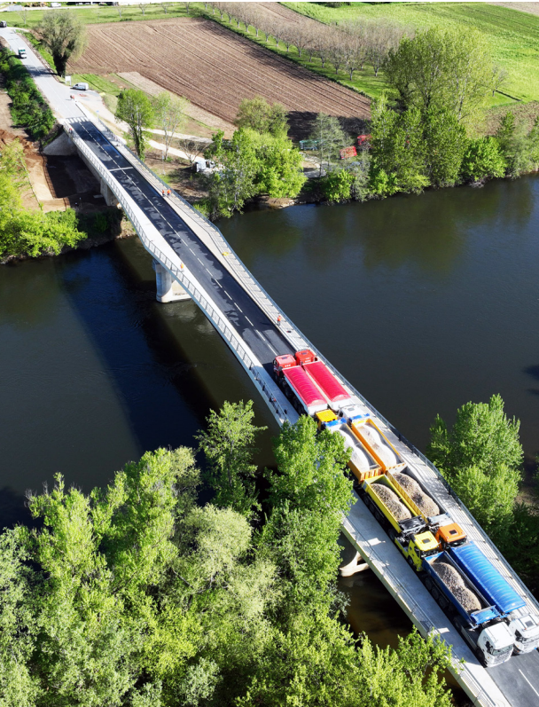
▼ Pont de Groléjac
