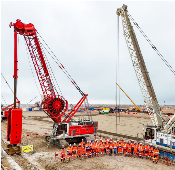
▼ NGE Fondations - Port-la-Nouvelle
