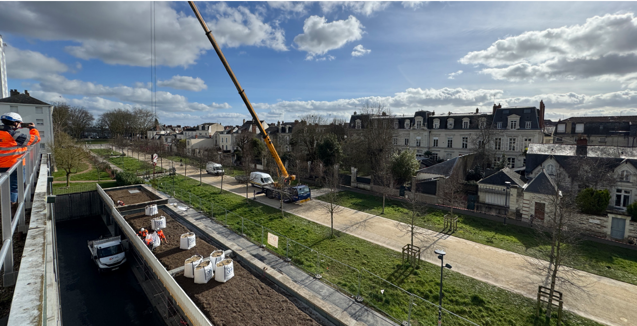
▼ Toiture végétalisée à Angers
