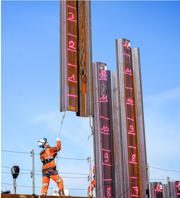
▼ Chantier passe à poisson à Beaucaire
