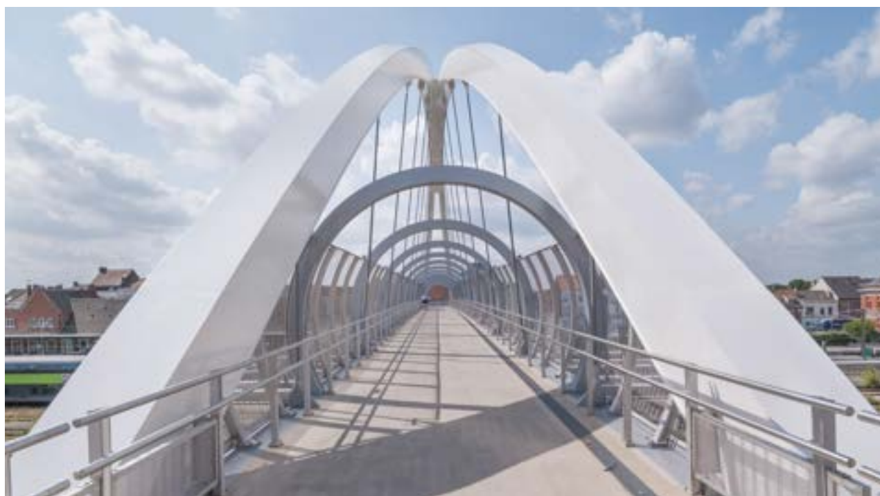
▼ Passerelle d'Hazebrouck terminée
