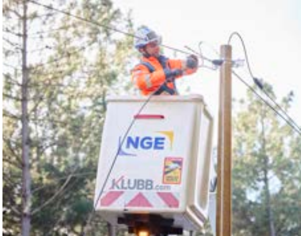
▼ Installation de la fibre en Gironde
