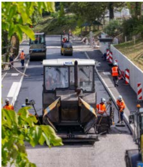
▼ Travaux de voirie à Chambéry
