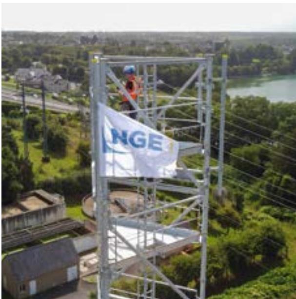
▼ Levage de pylône pour apporter la 5G dans la commune de La Richardais
