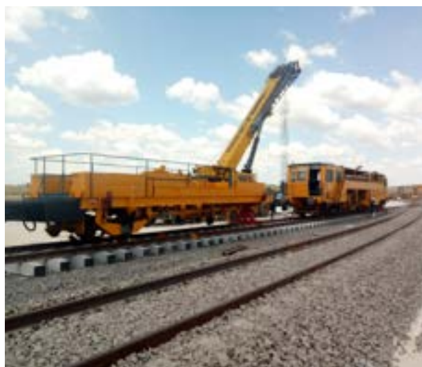
▼ Travaux sur la nouvelle ligne ferroviaire de 1 500 km au Mexique
