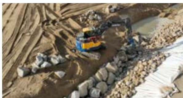
▼ Renforcement de l'ouvrage défense contre la mer à Jullouville
