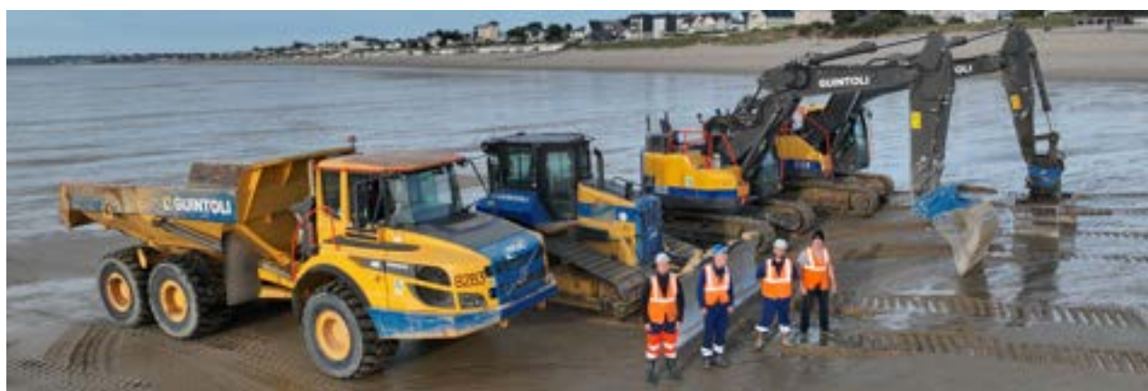
▼ Renforcement de l'ouvrage défense contre la mer à Jullouville
