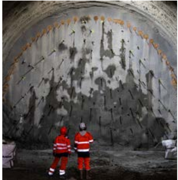
▼ Creusement du Tunnel Euralpin Lyon Turin
