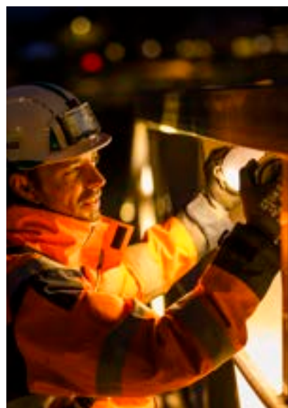
▼ Installation de l'éclairage à Ouistreham
