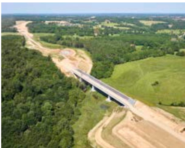
▼ Construction de la RN 141
