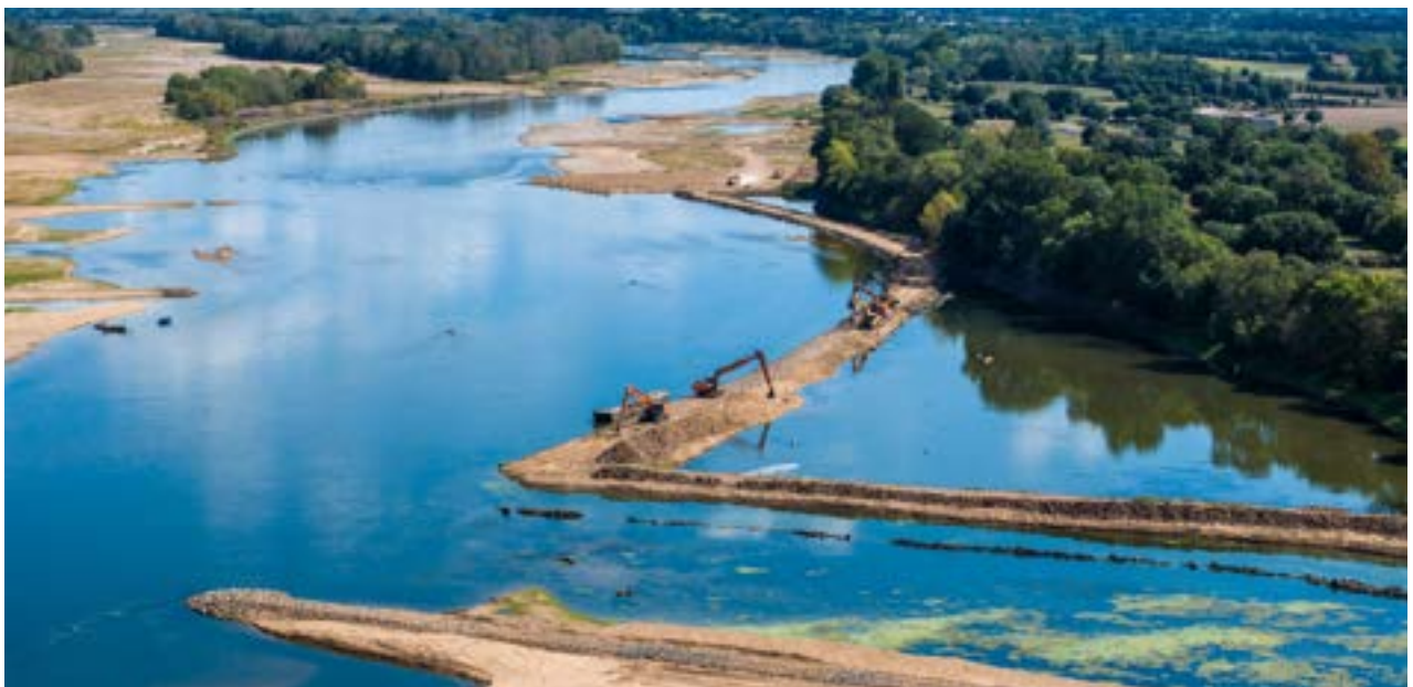
▾ Restauration du lit de la Loire
