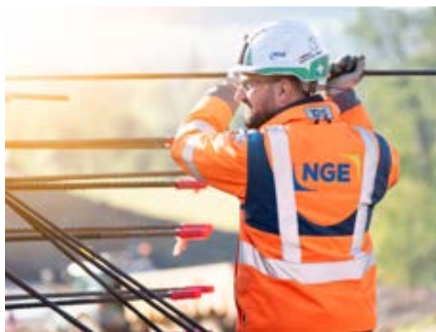
▼ Construction de la déviation sud-ouest d'Evreux en Normandie
