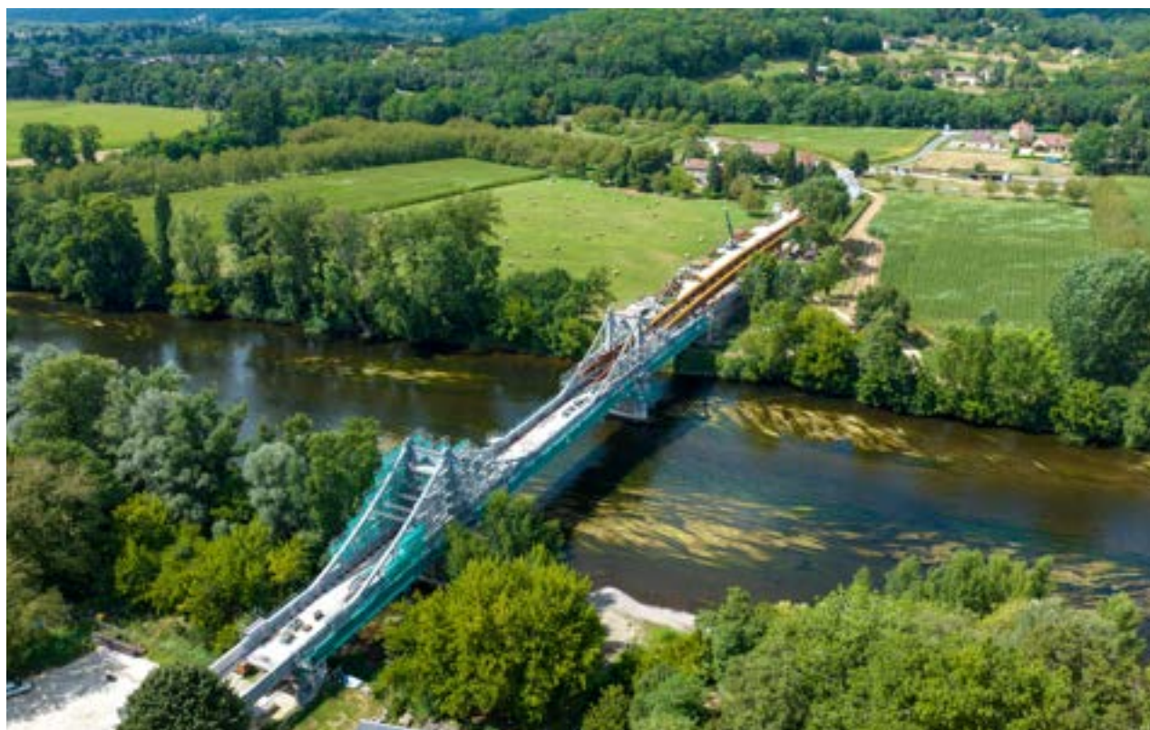
▼ Lancement du Pont de Groléjac en Aquitaine
