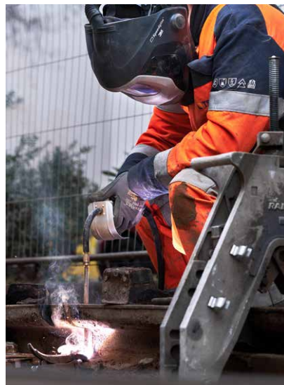
Première soudure des rails du tramway ligne 5 à Montpellier en juin 2023.
