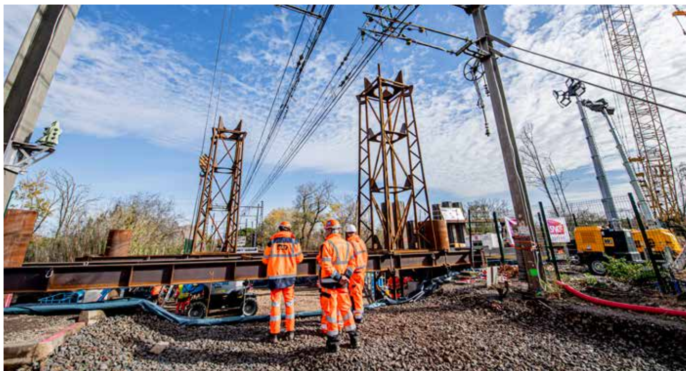
Création d'un passage à niveau dans l'Hérault
