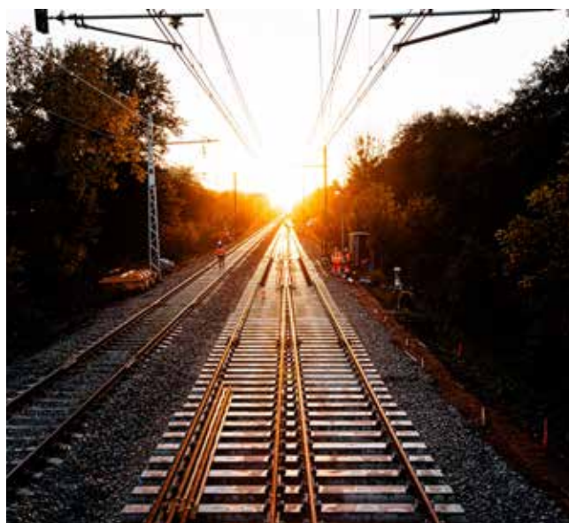
Chantier Vigirail à Connerré
