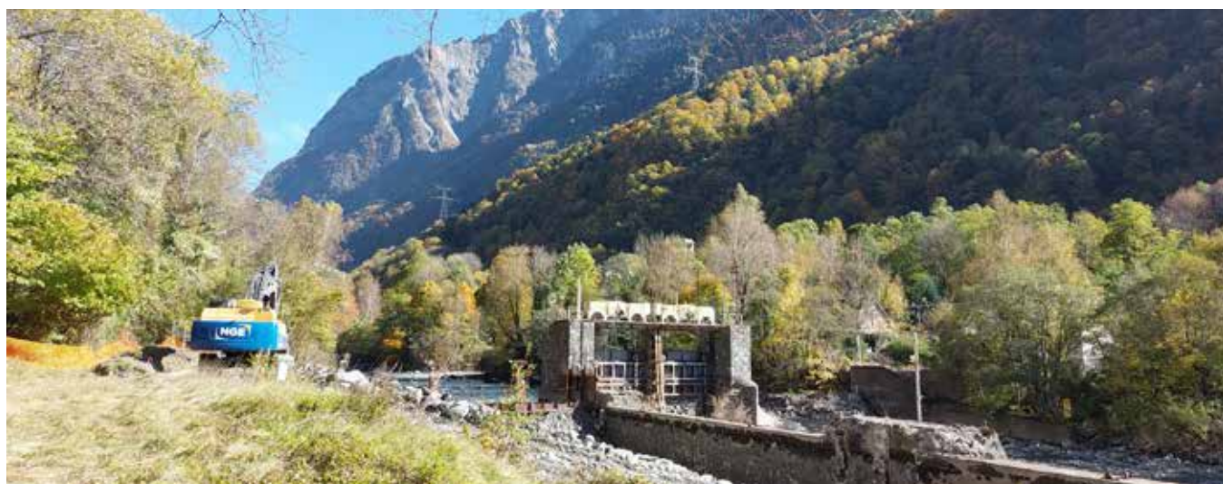
Travaux de renaturation en Moyenne Romanche
