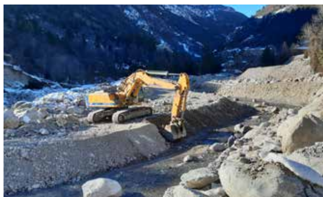
Travaux de renaturation en Moyenne Romanche
