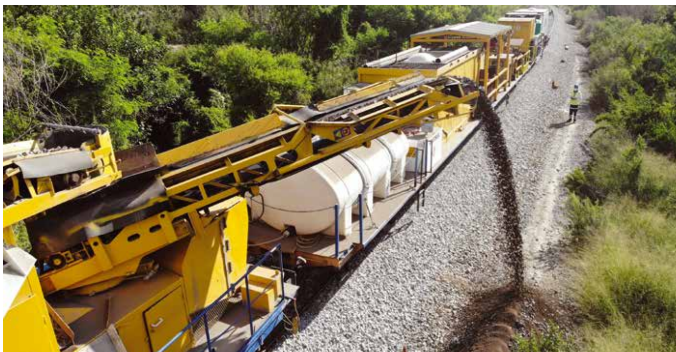
Travaux ferroviaires au Mexique
