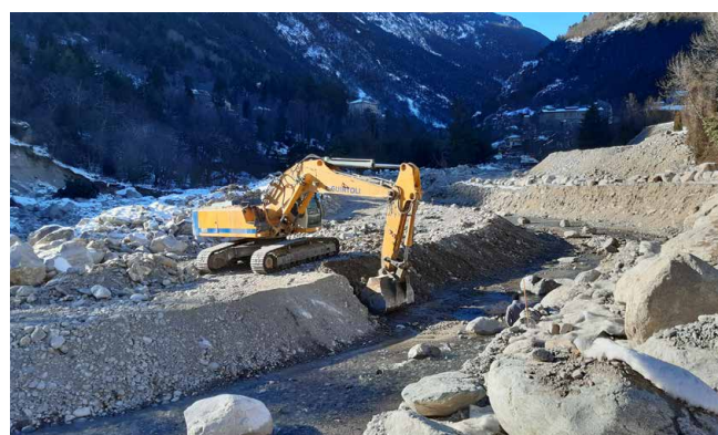
Trabajos de restauración en el Romanche Medio
