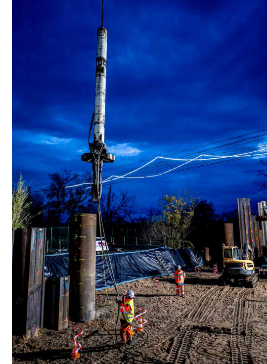
Sitio de construcción PN288
