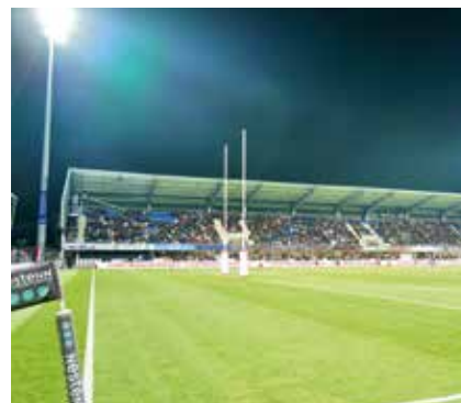
Diseño-construcción de la tribuna este del estadio Rabine de Vannes, entregada con dos semanas de anticipación, en diciembre de 2022.
