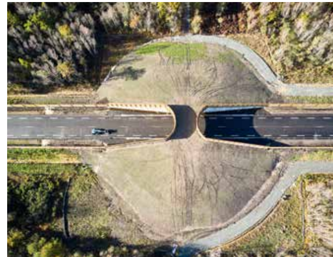
▼ Paso de fauna para la circunvalación Taillan-Medoc
