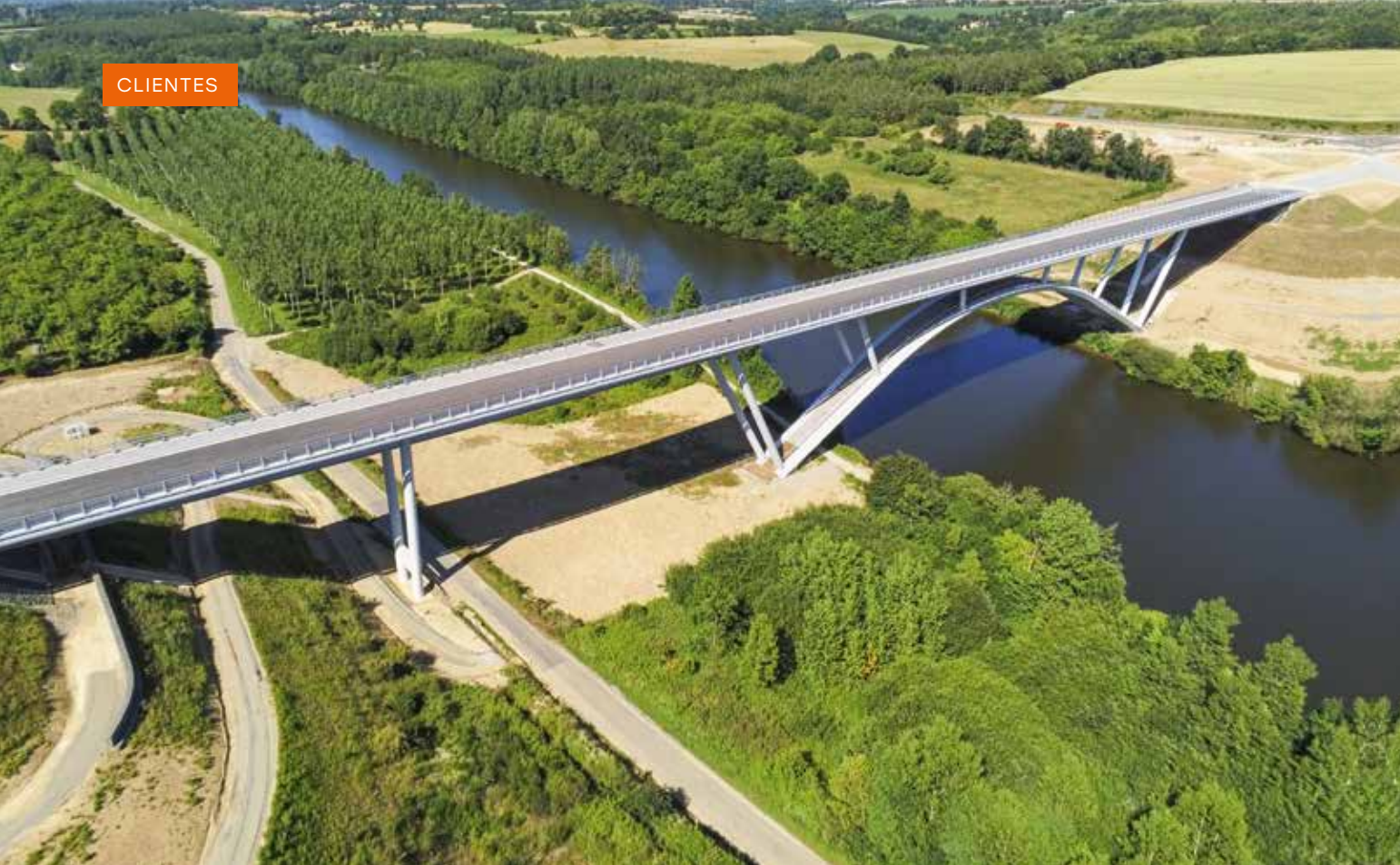
El viaducto de Mayenne, elemento clave del proyecto de circunvalación de la ciudad de Château-Gontier (País del Loira), inaugurado en octubre de 2022
