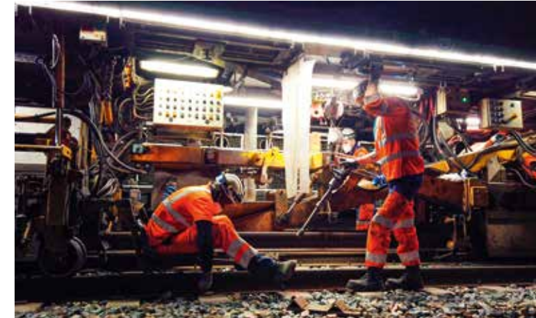
▼ Gracias a su tren fábrica, NGE está en condiciones de renovar 270 km de rieles al año
