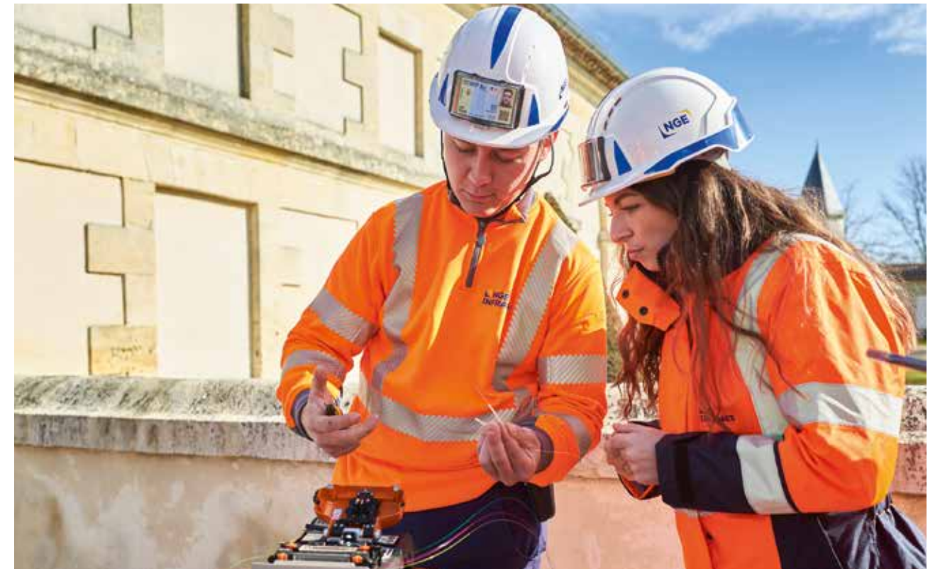
Despliegue de la fibra óptica en Dordoña
