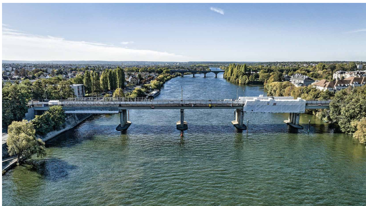
Renovación del puente Maisons-Laffitte (78)
