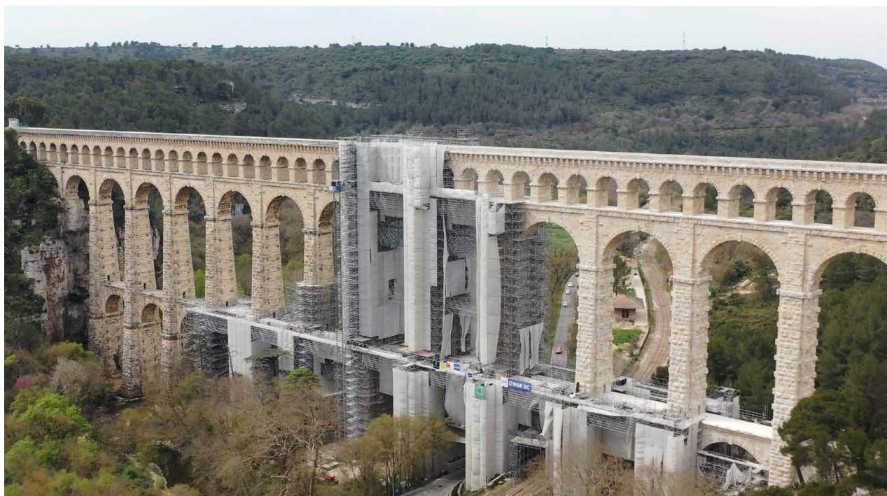
Renovación del acueducto de Roquefavour (13)
