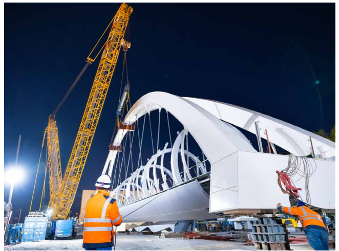
Instalación de la pasarela Hazebrouck (59)
