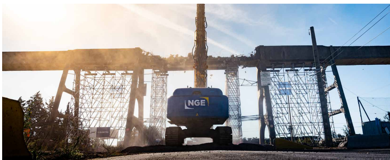
Deconstrucción del acueducto de Fourbine en Saint-Martin-de-Crau (13)
