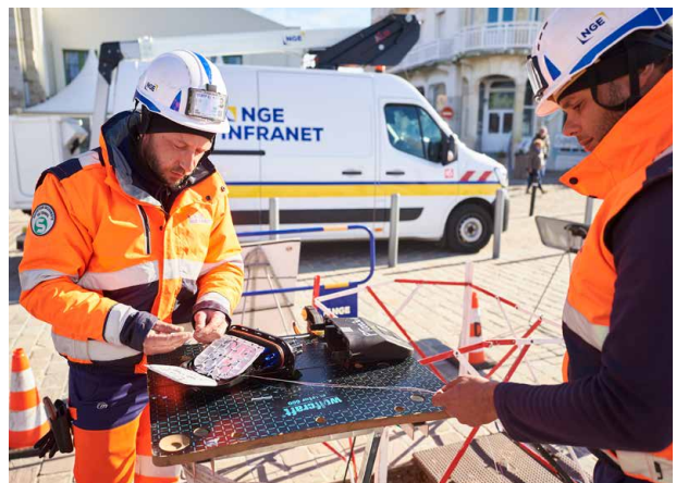
Despliegue de fibra óptica en Aquitania
