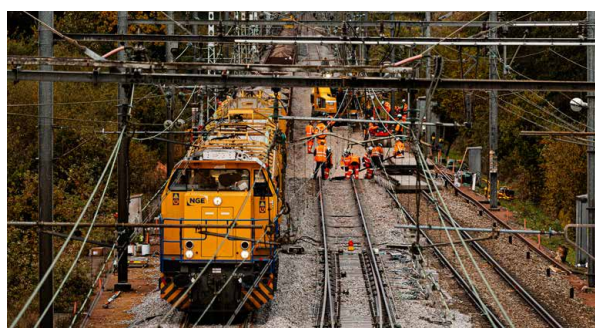
Sustitución de un desvío de carril LGV de 220 m de longitud en Connerré (72)
