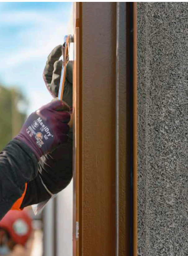
Mise en place des écrans acoustiques ► sur l'A57
