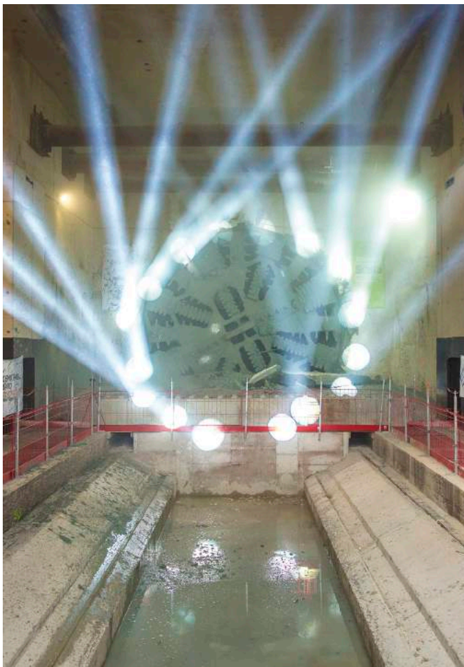
Le tunnelier Sofia arrive en fin de course à la station Serge Gainsbourg - Ligne 11
