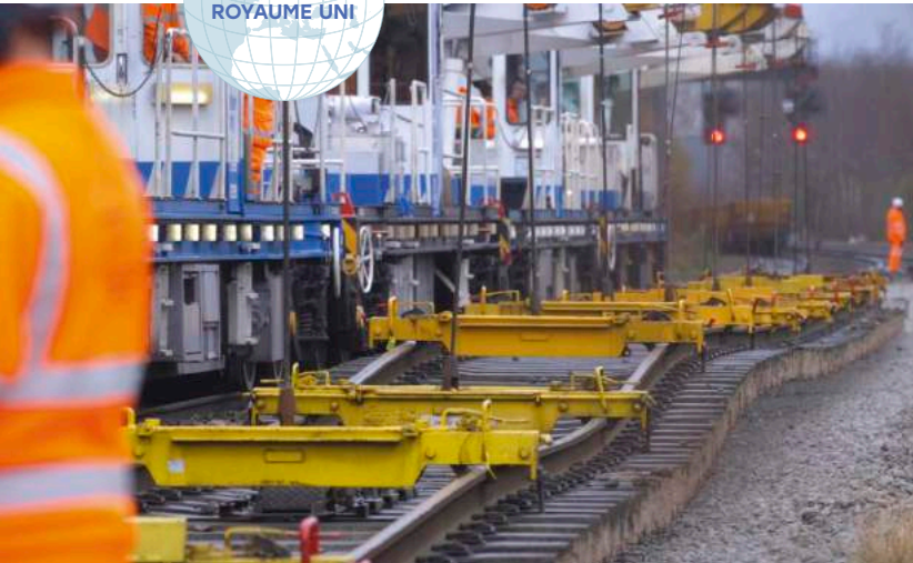
► Renouvellement de voies au Royaume-Uni
