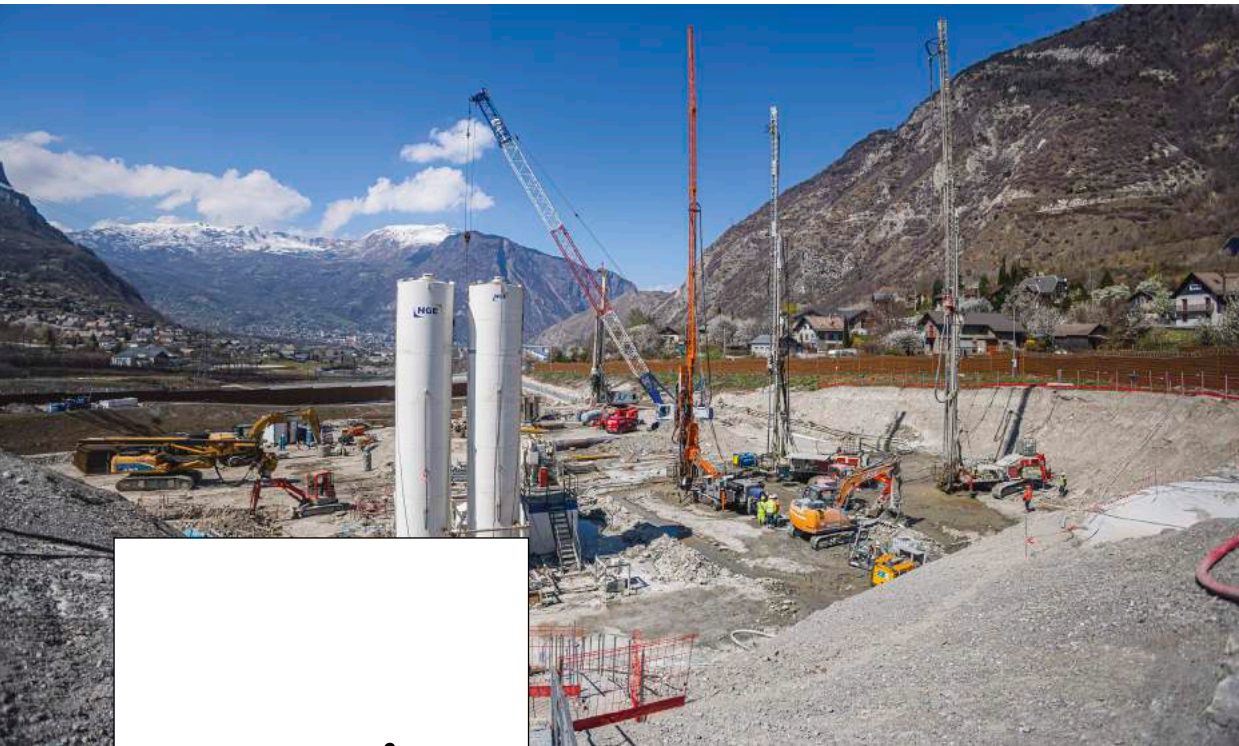
Travaux préparatoires pour le lot 3 du tunnel Lyon-Turin ▼
