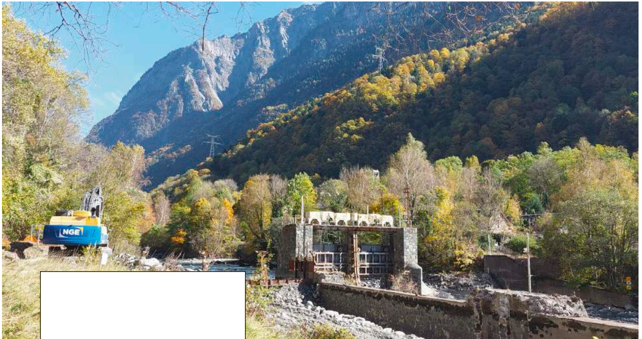
Travaux de renaturation en Moyenne Romanche ▼
