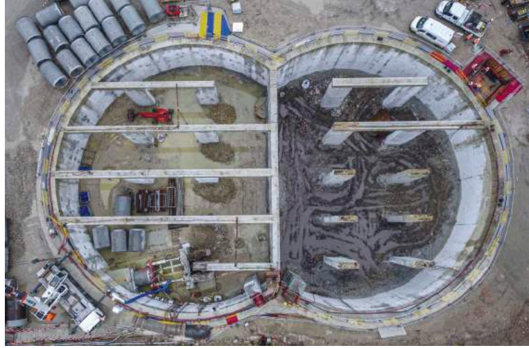
Bassin bi-lobe qui traitera les eaux pluviales de la station de dépollution à Champigny-sur-Marne ◀
