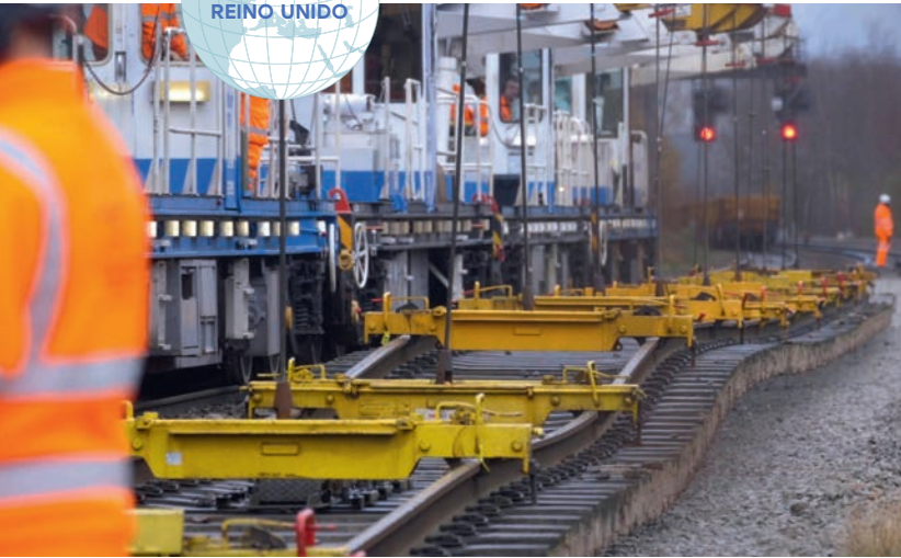
Renovación de vías en el Reino Unido
