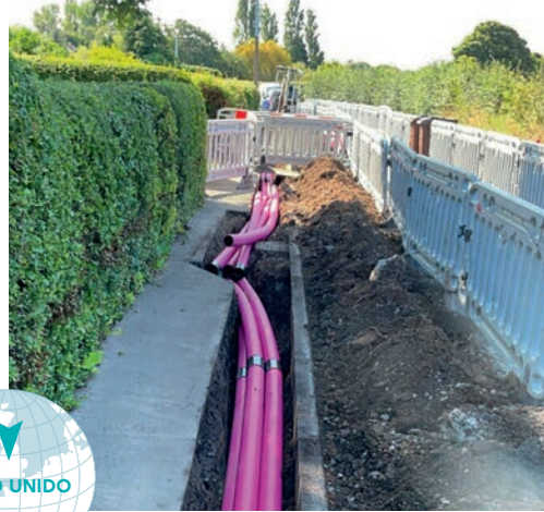
Primeras zanjas para desplegar la fibra óptica en Liverpool
