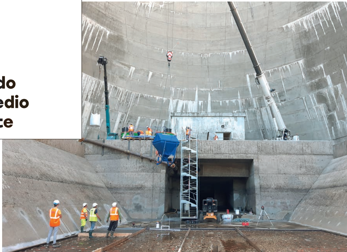
Renovación del estanque de Soulages en Saint-Chamond con cemento reforzado con fibras de alto rendimiento
