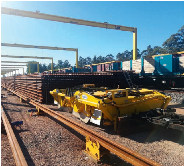
► Instalación de vigas de puentes ferroviarios y descarga de maquinaria
