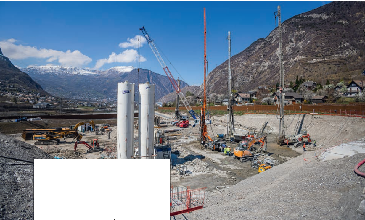
Obras preliminares del lote 3 del túnel Lyon-Turín ▼
