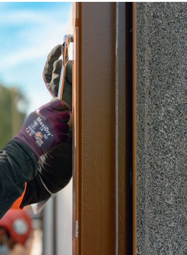
Instalación de barreras acústicas en la autopista A57
