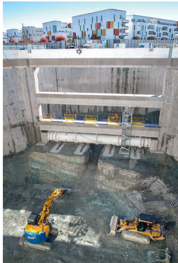
► Grand Paris Express: Estación Clichy-Montfermeil
