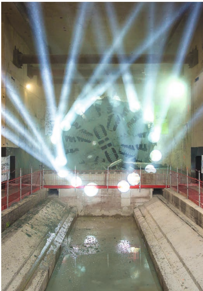
La tuneladora Sofía llega al final de su recorrido ▼ en la estación Serge Gainsbourg - Línea 11
