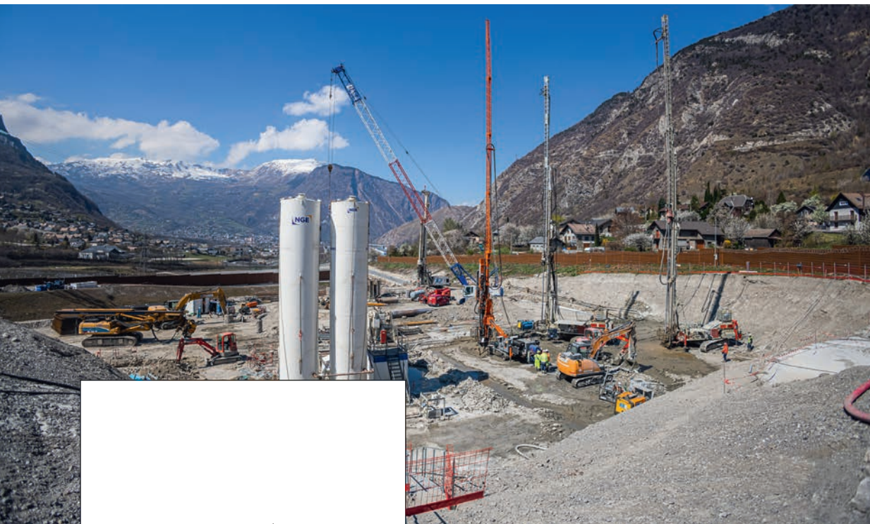
Obras preliminares del lote 3 del túnel Lyon-Turín ▼
