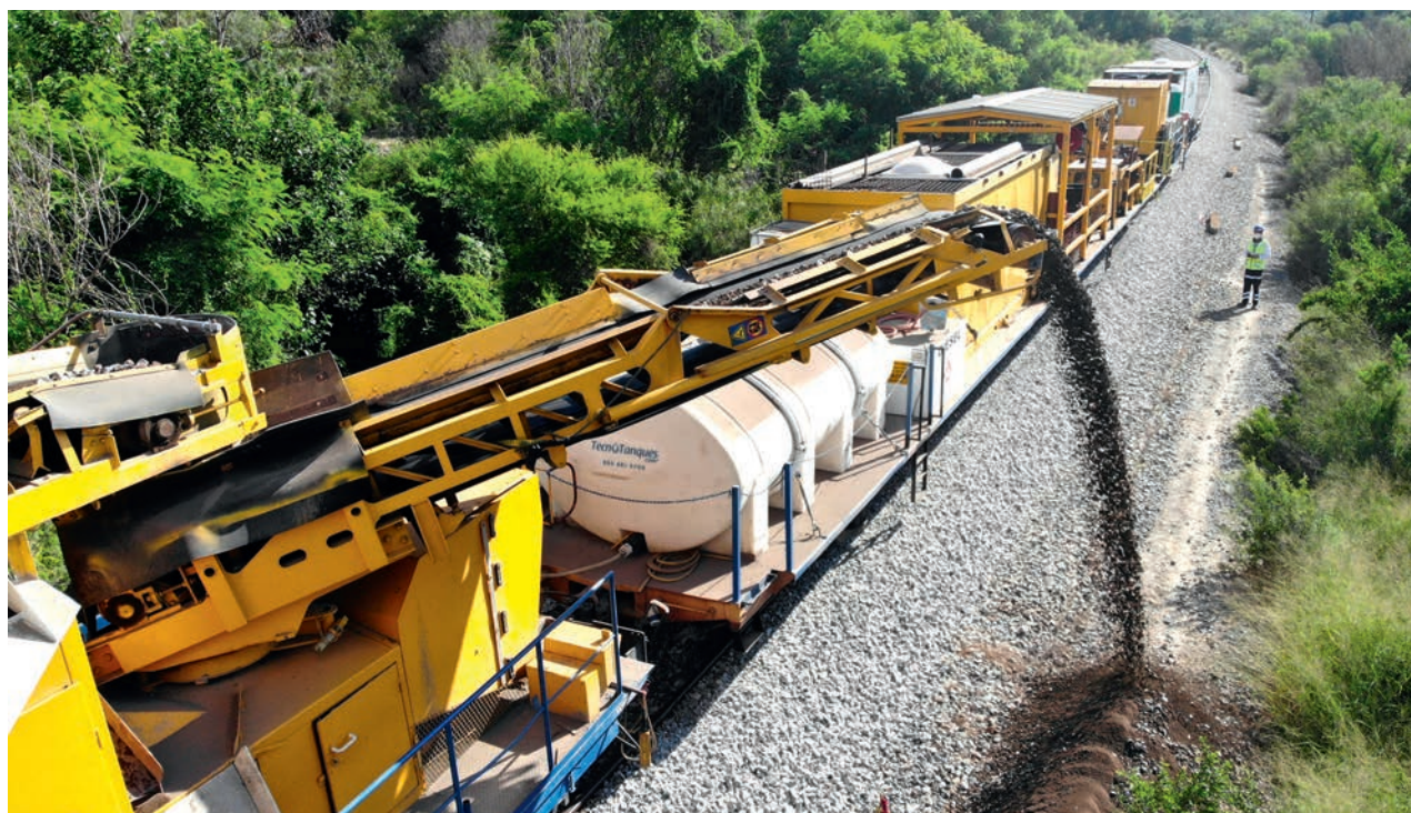
Obras ferroviarias en México
