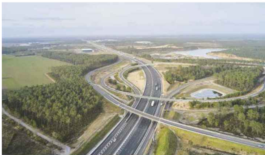
De 2017 à 2020, NGE, à travers ses filiales Guintoli, Agilis, Siorat, EHTP et NGE Génie Civil, a conduit les travaux de la section 8 de l'A63 sur 17 km entre Bénesse-Maremne et Saint-Geours-de-Maremne dans les Landes. L'ouverture à la circulation a eu lieu en avril 2020.
