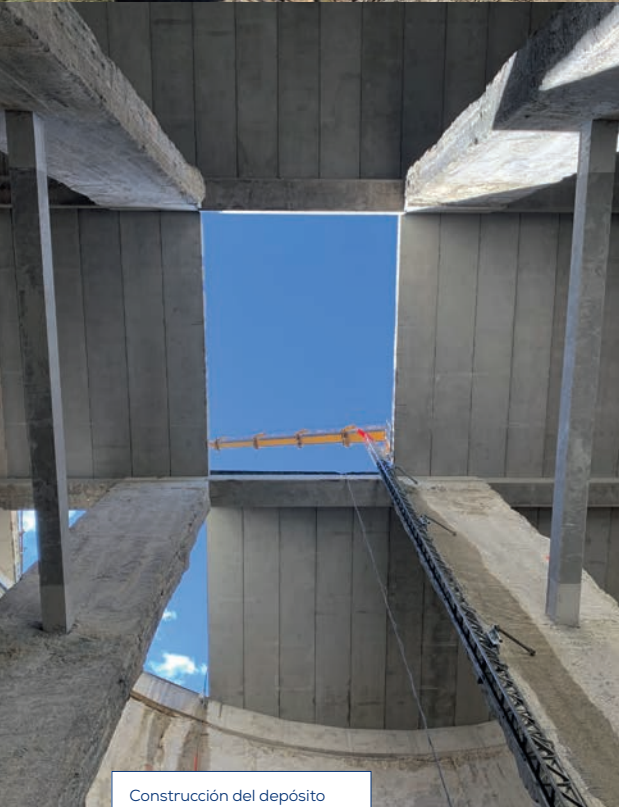
Construcción del depósito de Montreuil (Isla de Francia)
