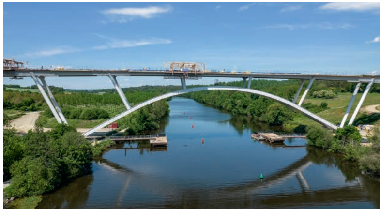
▲ Viaducto del Mayenne.
