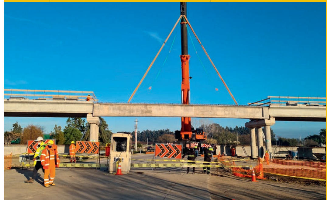
▲ Instalación de la viga de un puente ferroviario en Uruguay.
