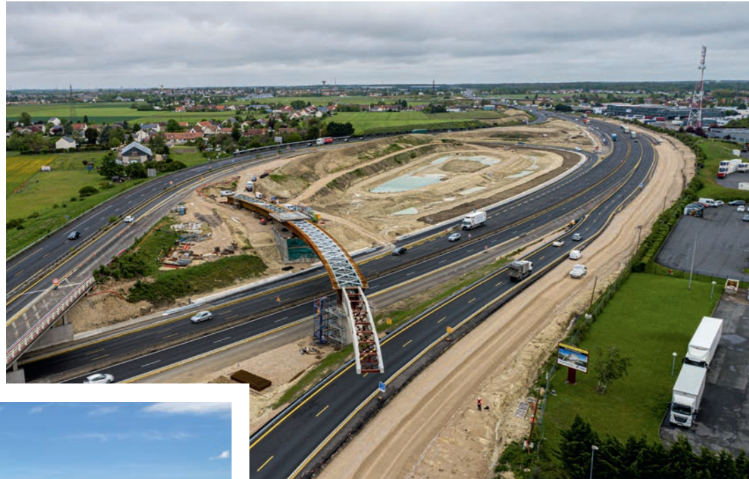
▲ Obras de acondicionamiento de la bifurcación A10/A71.
