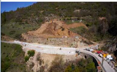
▲ El hormigón proyectado se sustituyó por paneles prefabricados de hormigón: un muro AD/OC® de 306 m<sup>2</sup>.
