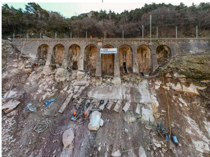
◀ Instalación de un muro AD/OC® para frenar el derrumbe de un talud en Sèvres y proteger la zona.
