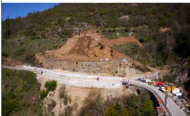
▲ Le béton projeté traditionnel a été remplacé par des écailles de béton préfabriquées : une paroi AD/OC® de 306m<sup>2</sup>.
