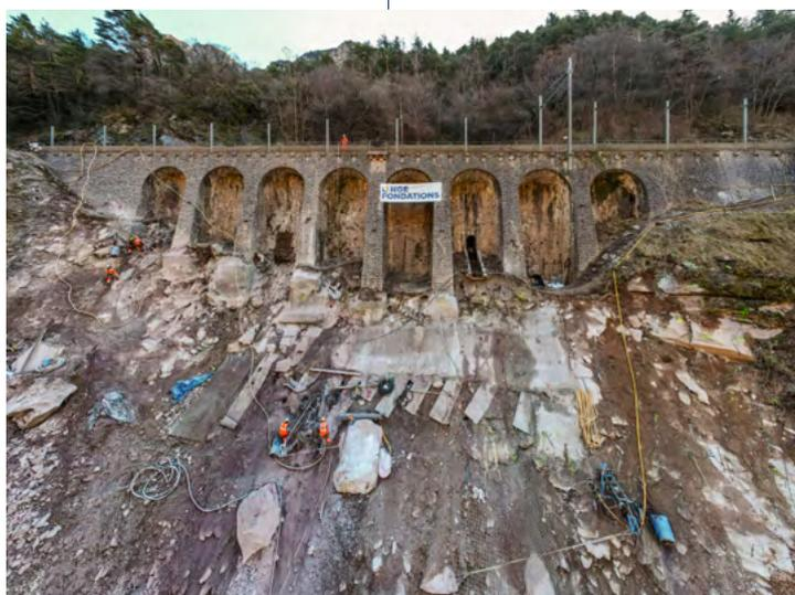
▲ Sur la commune de Fontan (06), confortement d'un talus grâce à la mise en place d'une énorme paroi clouée qui fait 70 mètres de long et 15 mètres de haut.
