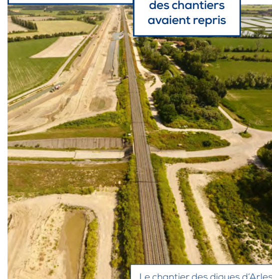
Le chantier des digues d'Arles a redémarré le 20 avril
