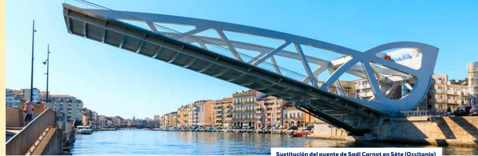
Sustitución del puente de Sadi Carnot en Sète (Occitania)
