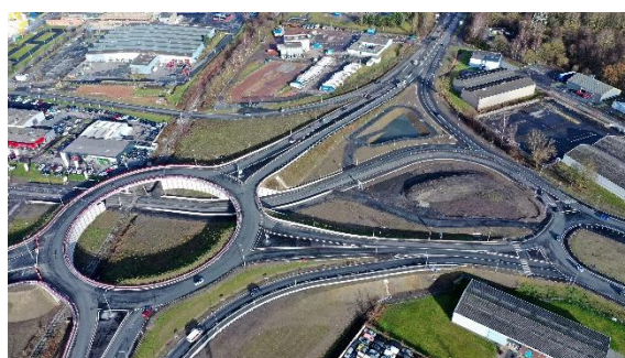
Giratoire dénivelé de Saint-Saulve
