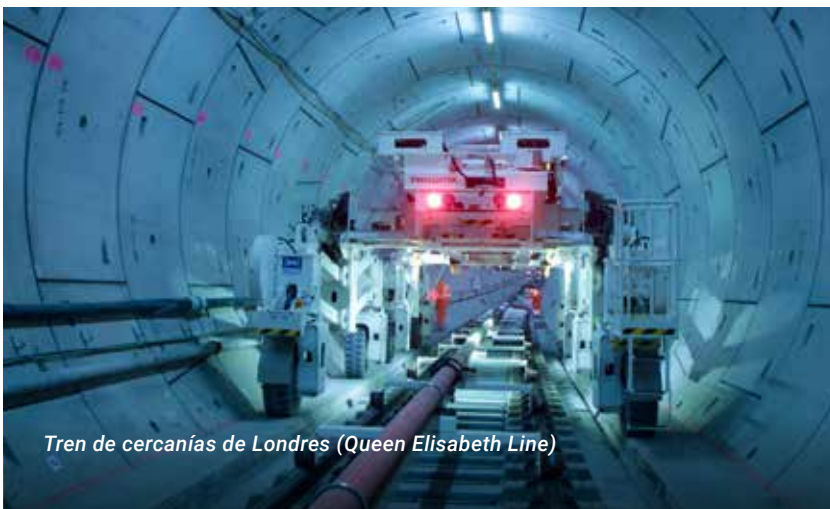
Proyecto ferroviario North/South Railway en Arabia Saudí. Construcción de 730 km de vías férreas en zonas desérticas
